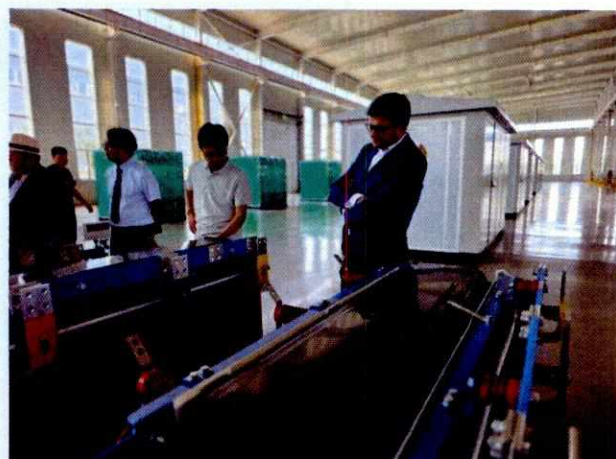
Fig. 33. Vizită în hală, în dreptul unui transformator uscat cu bobine și borne
